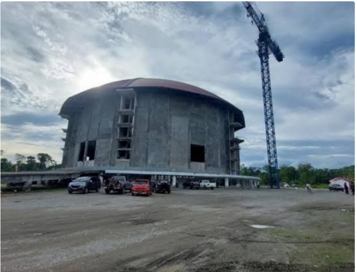
Pembangunan Gereja Kingmi Mile 32
